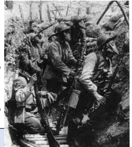
Des soldats dans une tranchée
